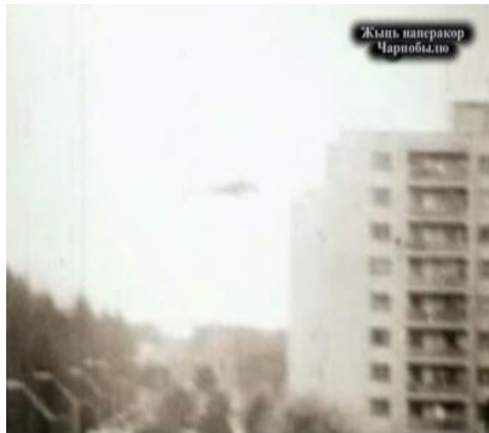
大きな団地群が廃墟となり、荷物の持ち出しはできず二度と戻ることはできなかった。
